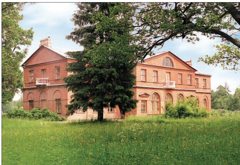
Приютино. Вид на господский дом. Фото 2003 г.
